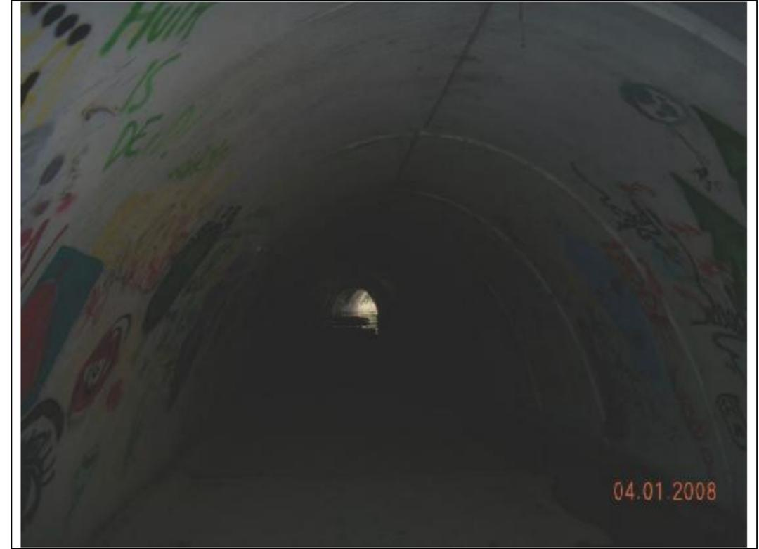
Fotografía 3 - En la segunda fotografía miramos el interior. La bóveda tiene 4,00 m de anchura y 3,50 de altura. Transita a todo lo ancho del vial y sus zonas aledañas, que conduce al Puerto de la Torre.
