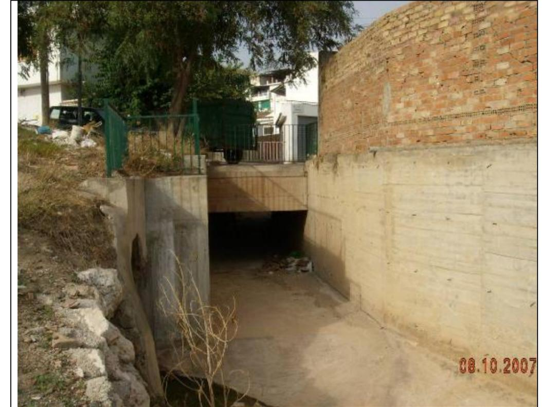
Fotografía 3 – Si nos fijamos bien podemos ver en el muro de la izquierda la salida del embovedado anterior. De frente vemos la obra de paso bajo un vial.
