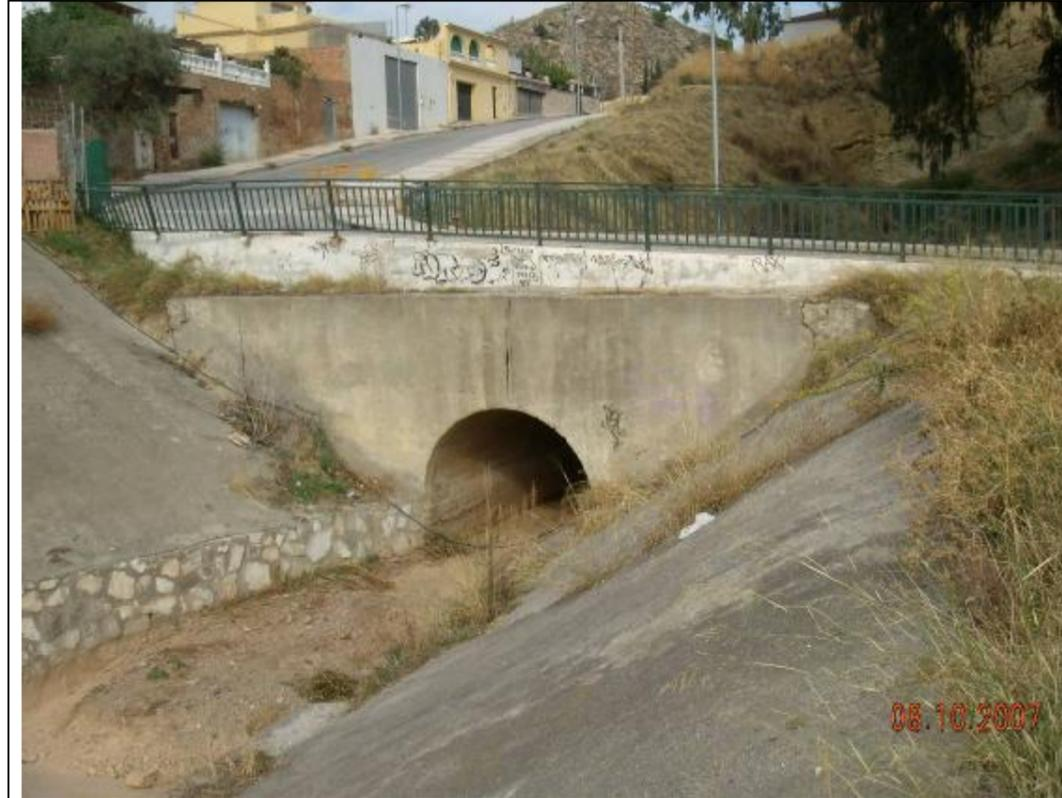
Fotografía 9 – El arroyo se conforma con taludes gunitados en su derivación hacia el este para realizar el trasvase. Tras pasar bajo el vial que mostramos avanza hacia el pie de la colina.
