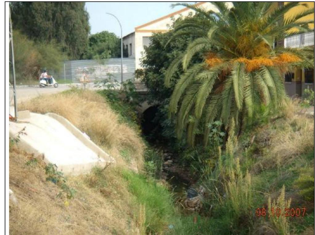
Fotografía 16 – Utilizando la alcantarilla que vemos en el centro de la fotografía, el arroyo cruza el último vial para desembocar, detrás de la valla metálica, en el de Los Ángeles.
